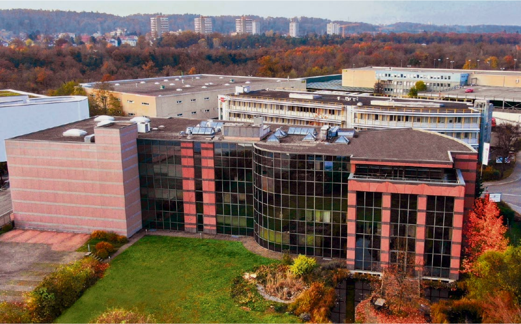
Damit Drossapharm die Bevölkerung jederzeit mit wichtigen Medikamenten versorgen kann, produziert das Unternehmen in der Schweiz (Hauptgebäude in Arlesheim). Bilder: zvg
